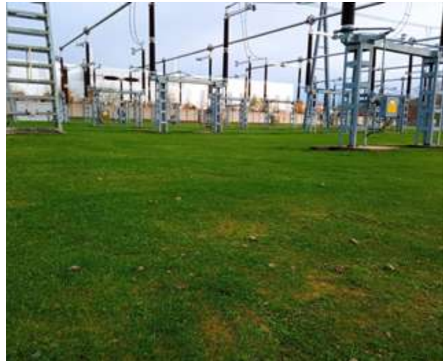
Semis végétal par Hydromulching 1 mois après sa mise en œuvre.
